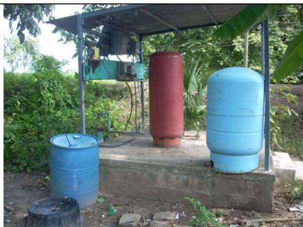
Fotografía 12: Sistema de abastecimiento de agua de El Sacrificio y sistema de clorinación
