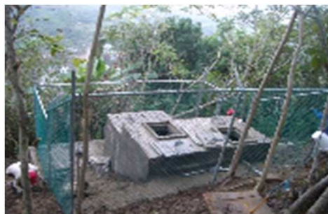
CAJA DE CAPTACION
