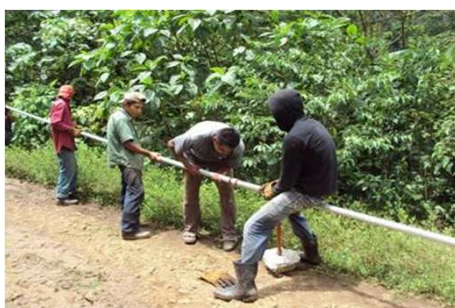
INSTALACION DE TUBERIA DE FOGO.
