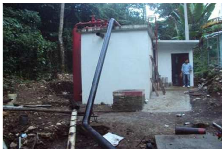
CONSTRUCCION DE CASETA.
